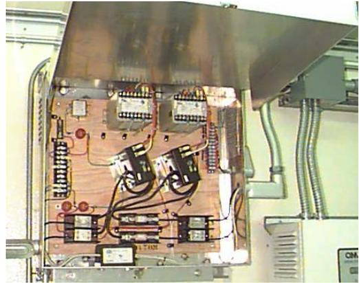
**Figure 20. System 4 AC Junction Box**
